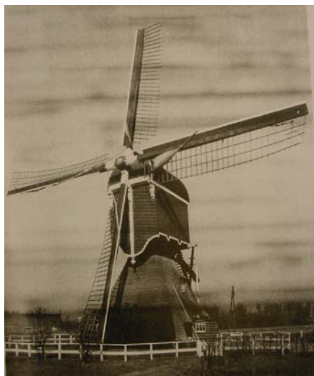
Wipwatermolen aan de Vlist in Bonrepas Hier draait het gehele vierkante deel
