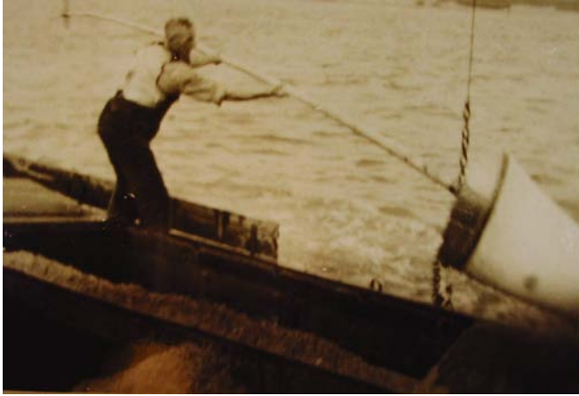
Jan van Dam Dkz. van het schip de 'Spes Salutis' baggert op de Lek zijn schuit vol met een beugel.
