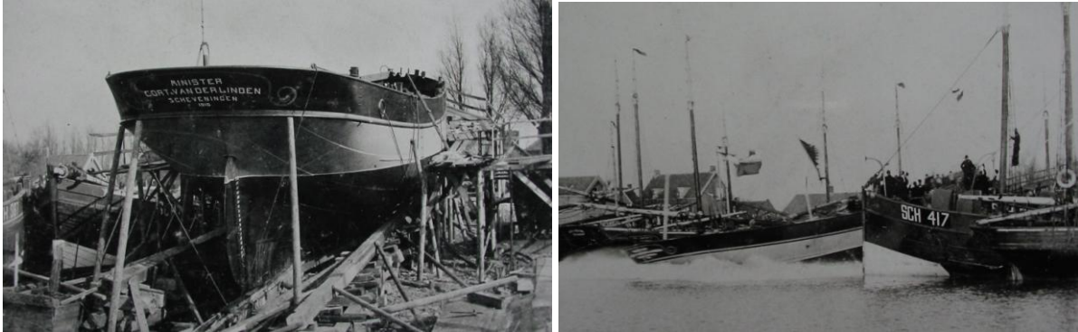
Twee maal de ijzeren logger Minister Cort van der Linden gebouwd in Krimpen aan den IJssel. Links kun je de goten zien waarop het schip stond en de houtenpalen die het recht overeind moesten houden tijdens de bouw. Op de foto rechts is het zojuist met zijn achtersteven in het water beland.
