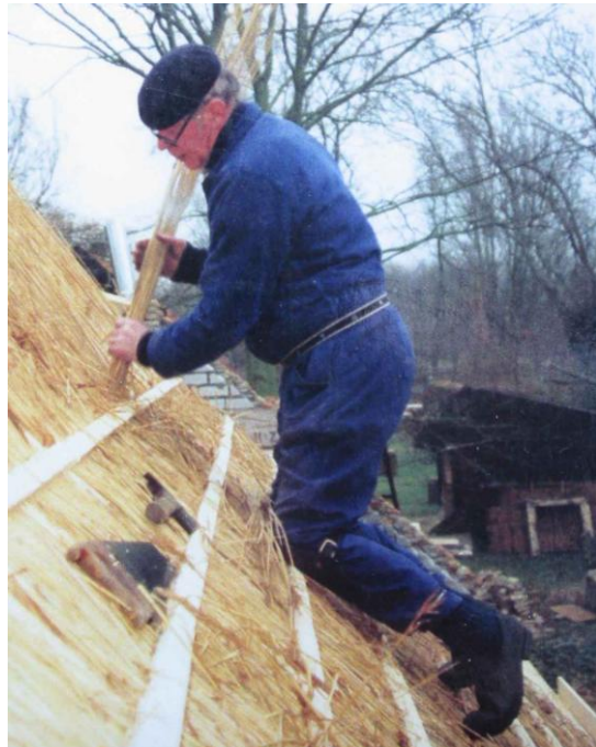
De rietdekker aan het werk
